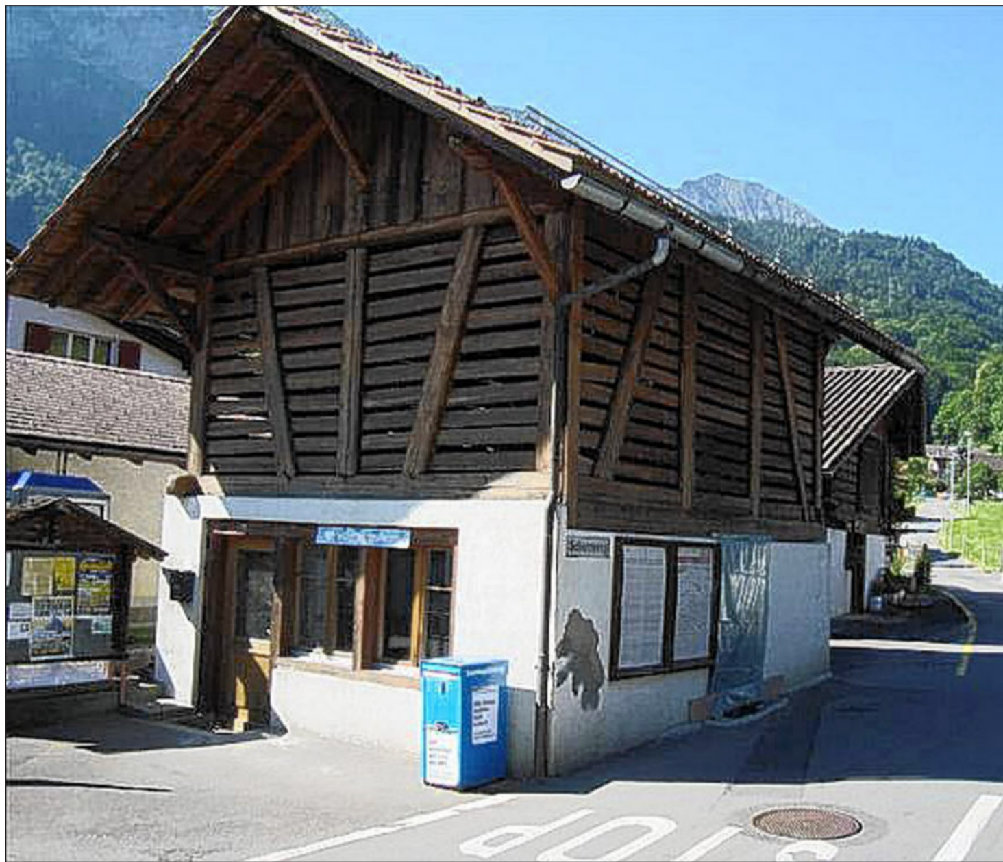
Die Sternen-Scheune in Därligen wird abgebrochen.
